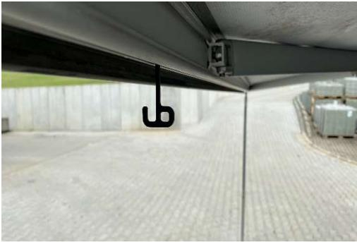
2. Haken in die Kederschiene der Markise einfädeln
