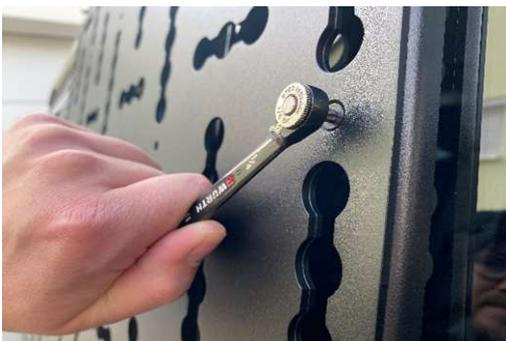
4. Toolboard mit den im Lieferumfang enthaltenen Schrauben befestigen
